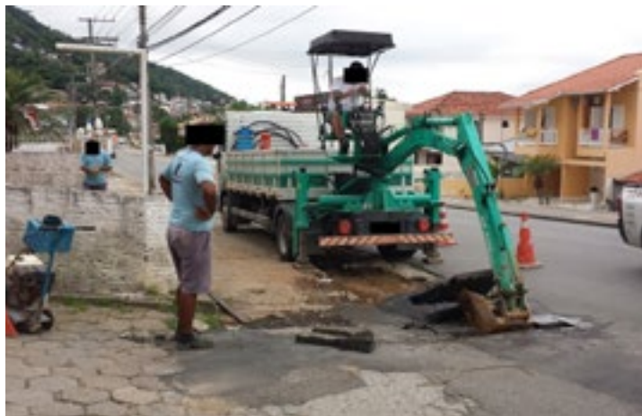
Trabalhadores e equipamentos da Casan colocados à serviço da empreiteira, em Florianópolis.
