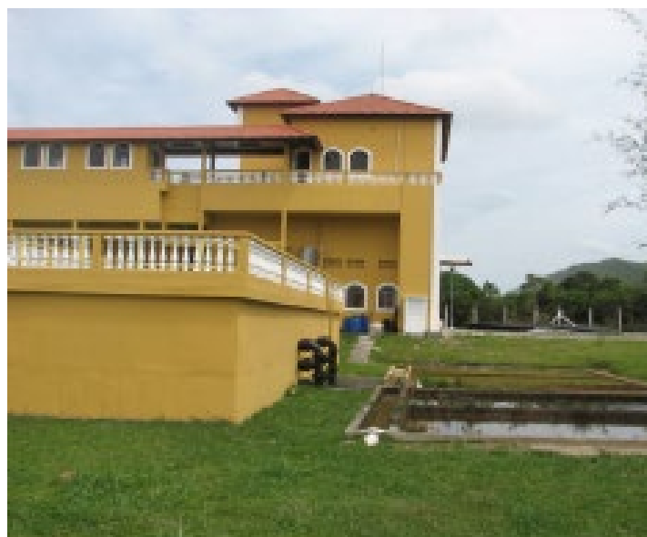
ETA da Lagoa do Peri - Florianópolis.
