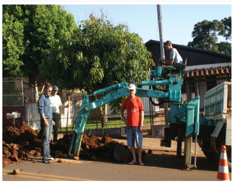
Trabalhadores de Maravilha em atividade na manutenção/operação
